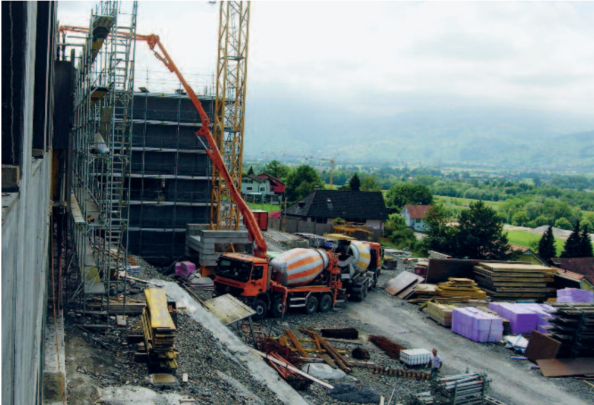
Baustelle Projekt Primarschule und Kindergarten
