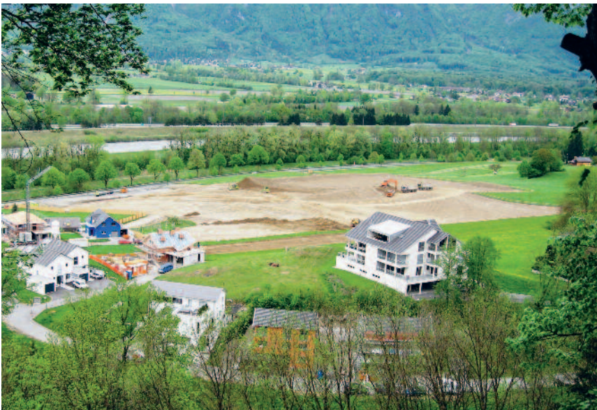
Blick auf das Gelände der zukünftigen Freizeit- und Sportanlage Grossabünt
