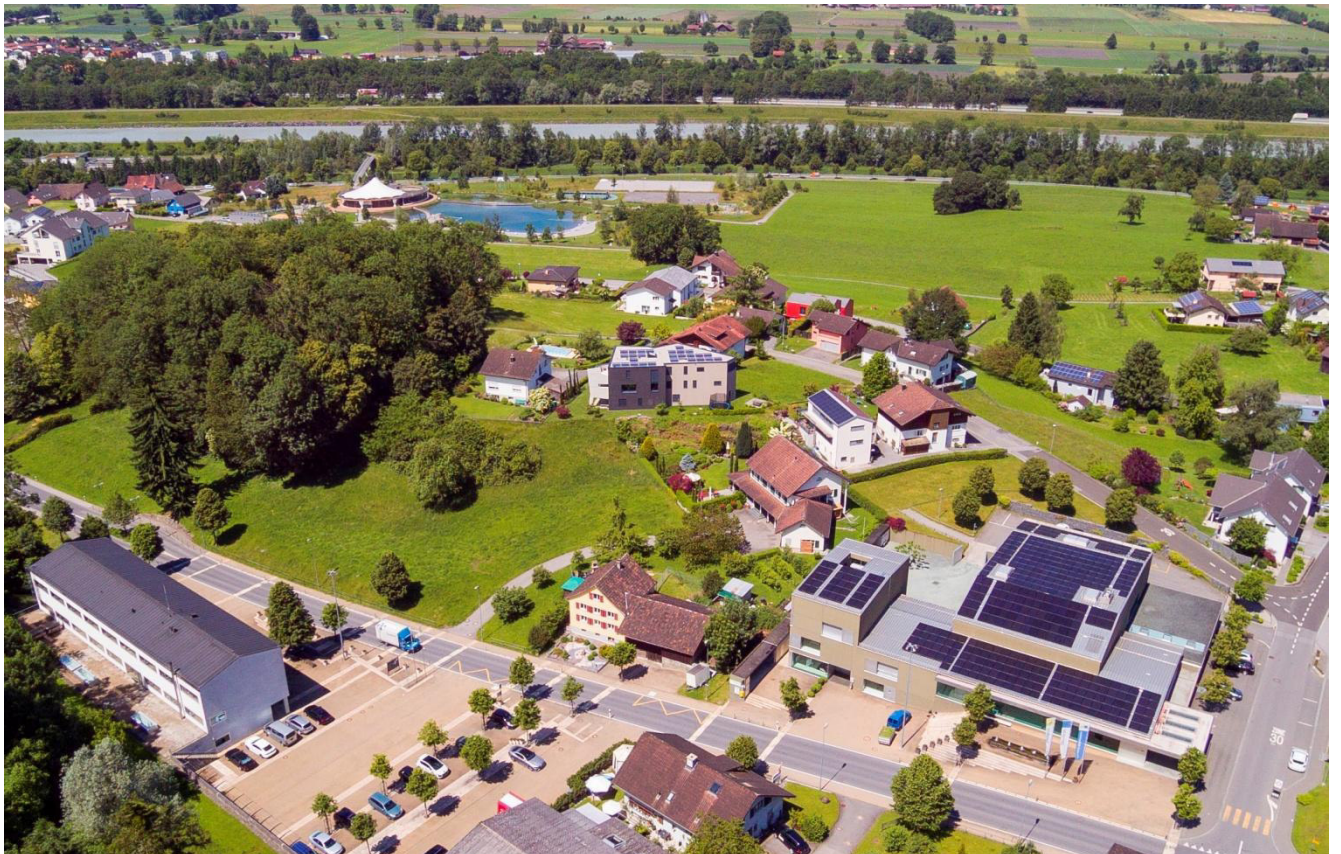
Photovoltaikanlage auf dem Gemeindehaus (Foto Paul Trummer)
