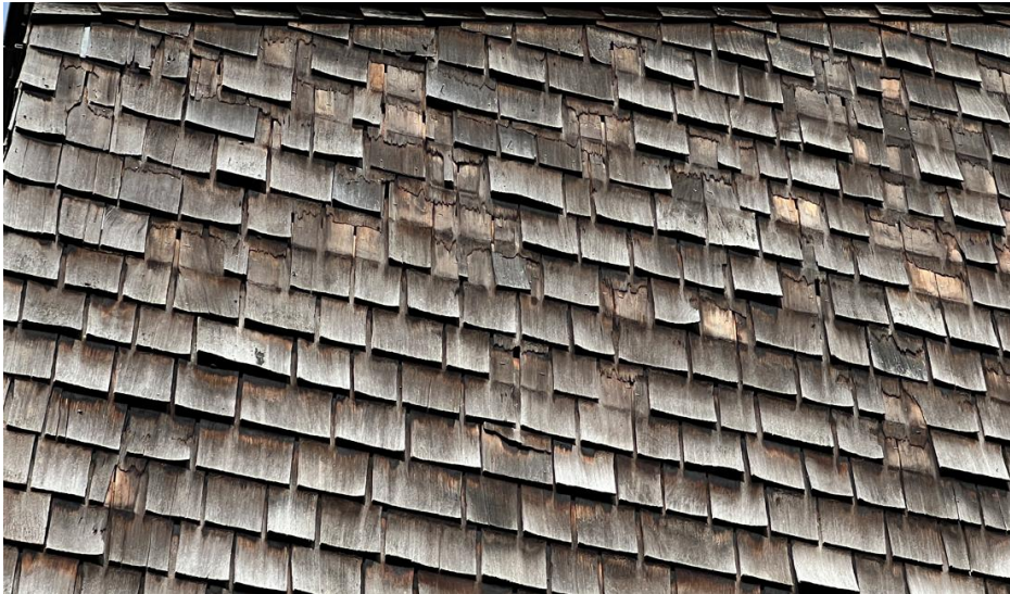
Schadhafte oder fehlende Schindeln unterhalb des Daches
