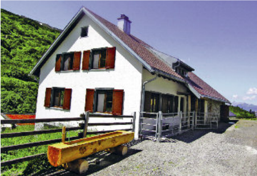
Die sanierte Alphütte Rauz
