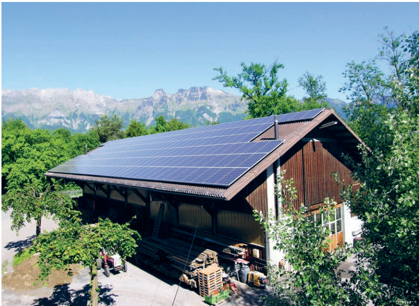
Photovoltaikanlage auf dem Werkhof.
