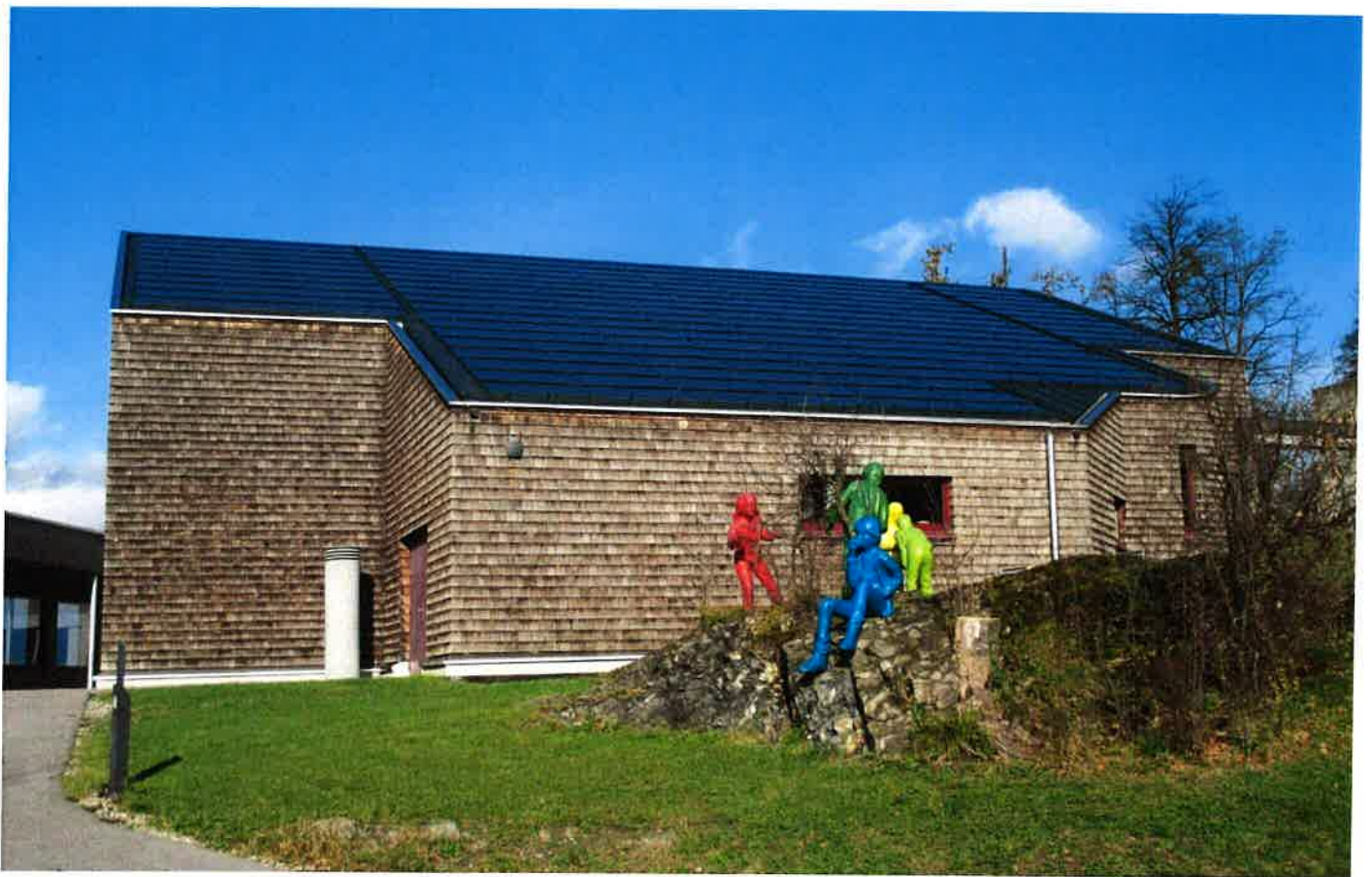
Photovoltaikanlage (Turnhalle der Primarschule Gamprin)
